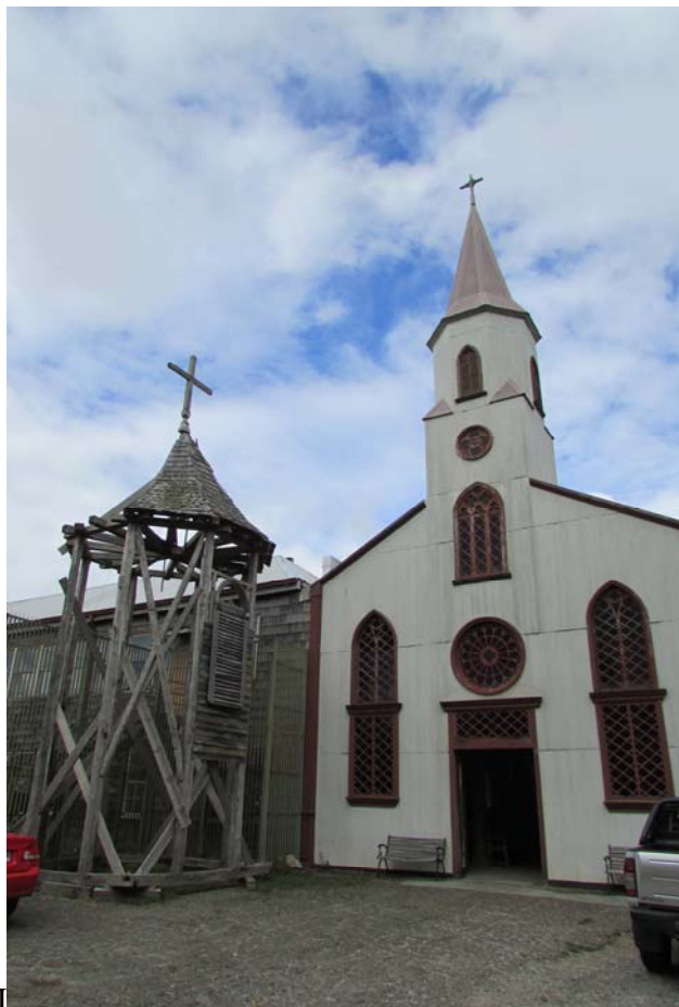
Iglesia de Ancud en proceso de restauración.
